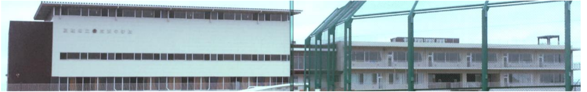
<亘理町> 津波の経験から、水が抜ける構造を取り入れた荒浜中学校
